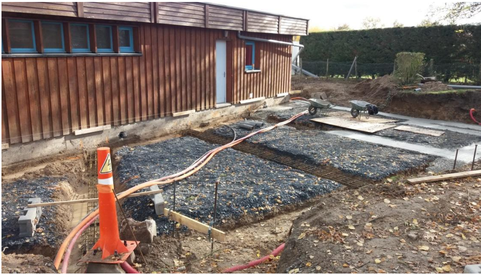
13 novembre Fondations de l'agrandissement
